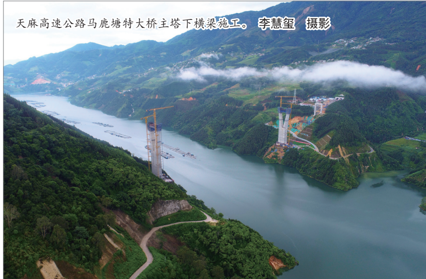
天麻高速公路马鹿塘特大桥塔下横梁施工。李慧玺 摄影
