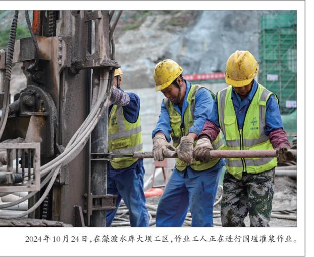
2024年10月24日，在藻渡水库大坝工区，作业工人正在进行围堰灌浆作业。
