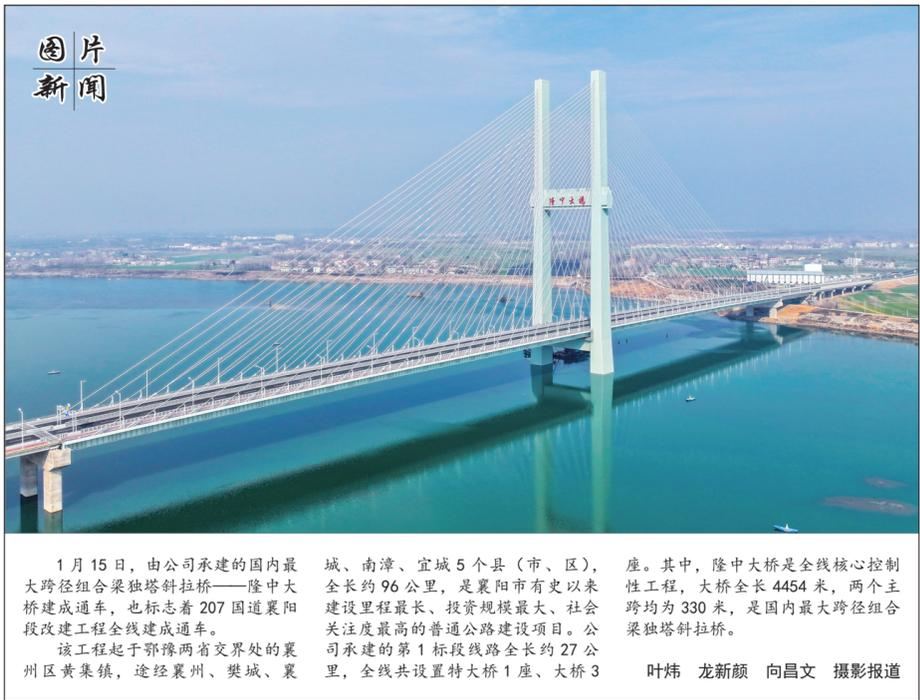
1月15日,由公司承建的国内最大跨径组合梁塔斜拉桥——隆中大桥建成通车,也标志着207国道襄阳段改建工程全线建成通车。该工程起于鄂豫两省交界处的襄州区黄集镇,途经襄州、樊城、襄阳、南漳、宜城5个县(市、区),全长约96公里,是襄阳市有史以来建设里程最长、投资规模最大、社会关注度最高的普通公路建设项目。公司承建的第1标段线路全长约27公里,全线共设置特大桥1座、大桥3座。其中,隆中大桥是全线核心控制性工程,大桥全长4454米,两个主跨均为330米,是国内最大跨径组合梁塔斜拉桥。
